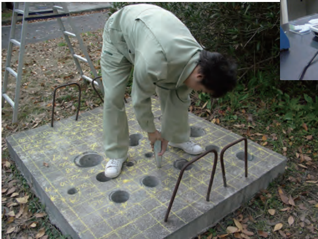
コンクリートの非破壊試験
