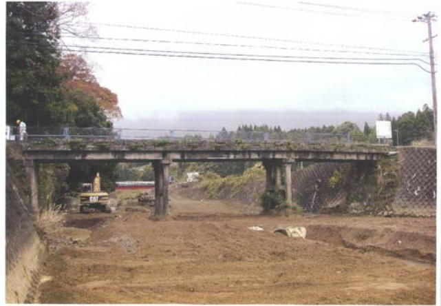
解体直前の相場橋
