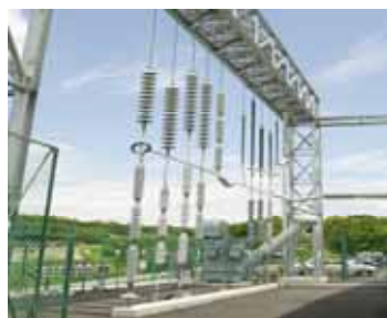
屋外課電曝露試験
