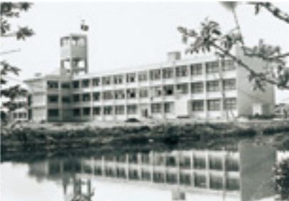
1号館（昭和39年3月竣工）
