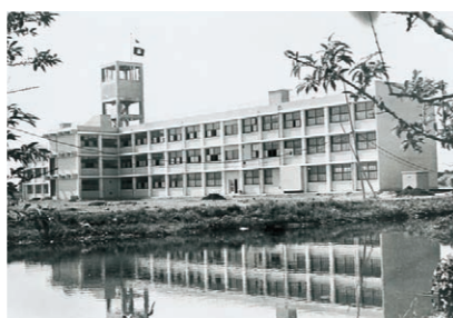
1号館（昭和39年3月竣工）
