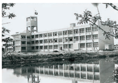
1号館（昭和39年3月竣工）
