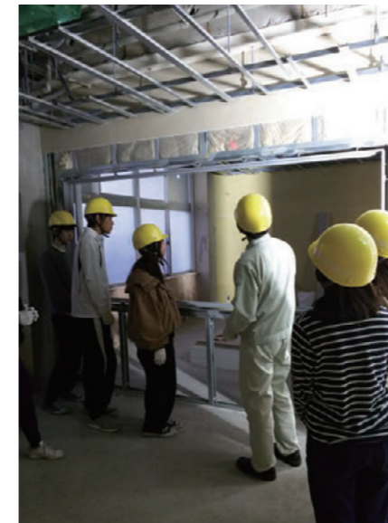
A科棟改修現場見学
