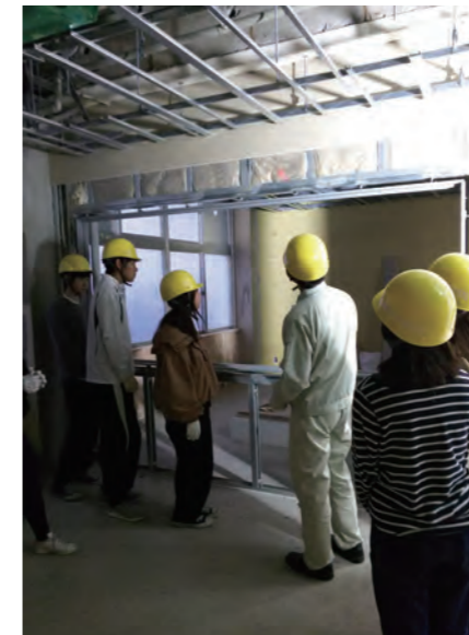
A科棟改修現場見学
