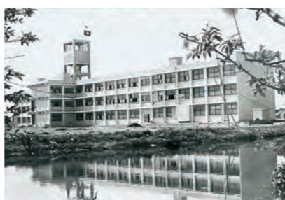
1号館（昭和39年3月竣工）
