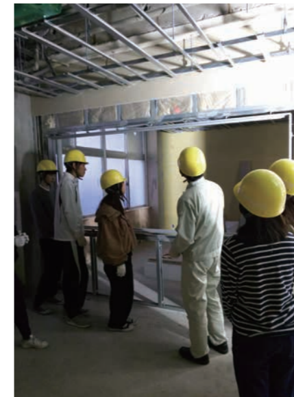
建築学科棟改修現場見学
