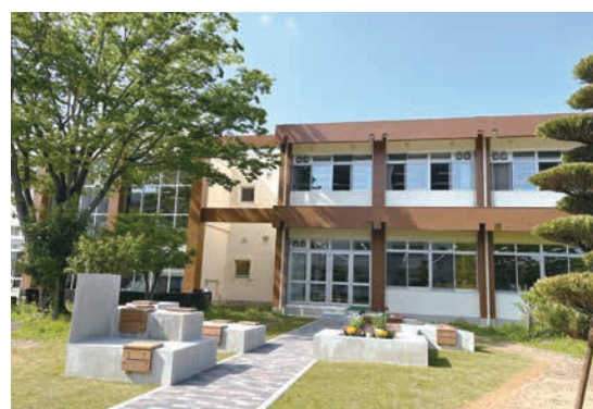
言ノ葉テラスから図書館棟外観
