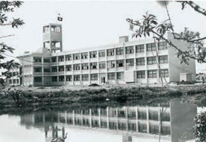
1号館（昭和39年3月竣工）
