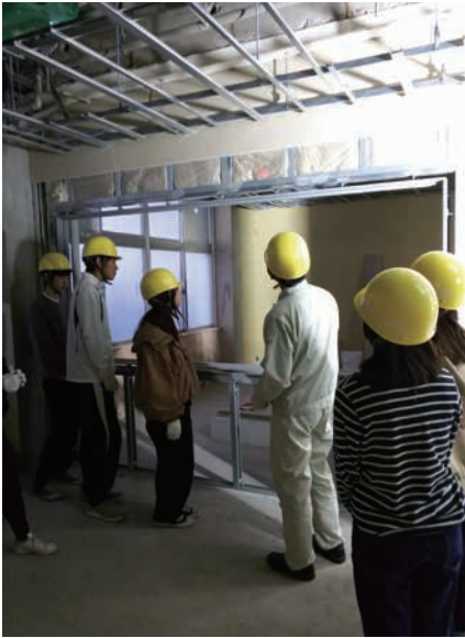
建築学科棟改修現場見学
