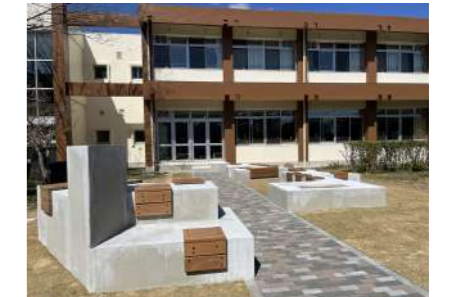
令和4年度整備後写真（前庭から）
