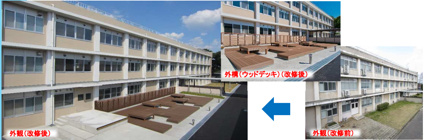
3号館(機械工学科校舎) 竣工(改修):2013.9/規模:地上3階 1,780㎡ 教育研究の高度化・多様化への対応、共同研究・受託研究への取り組みの推進等を目的とし、老朽施設の機能改善・充実を図る施設として、3号館(機械工学科校舎)の大規模改修(内外部改修)を実施
