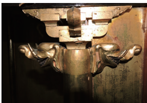
写9 内部柱頂部の木鼻と斗拱
