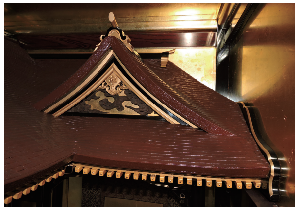
写17 宮殿屋根右部
