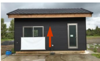
図3 プルアップ型遮蔽装置
